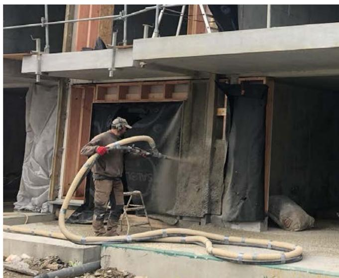
*Foto 2: Beispiel für das mechanische Spritzen von Hanfbeton auf eine innere verlorene Schalung aus Gipskartonplatten.*
