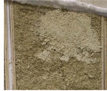
*Foto 7: Hanfbeton am Ende der Nachbearbeitung mit Verspachtelung des abgelösten Teils.*
