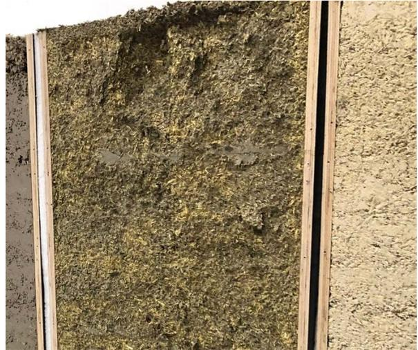
*Foto 4: Ungleichmäßiger Hanfbeton mit punktueller Ablösung.*
