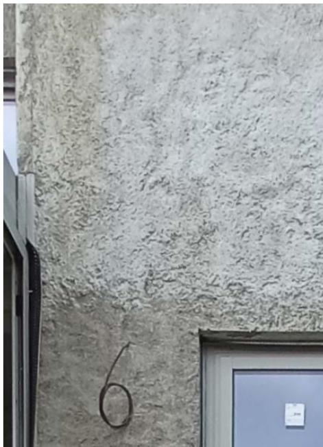
*Foto 1: Hanfbeton während des Trocknungsprozesses. Bereich oben trockener und unten feuchter.*
