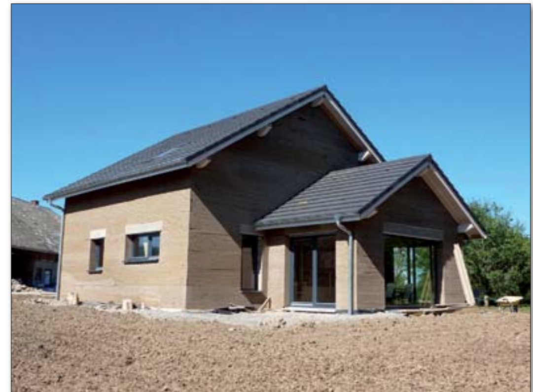
Fertiggestellter Rohbau eines ökologischen Hauses aus Hanfbeton
