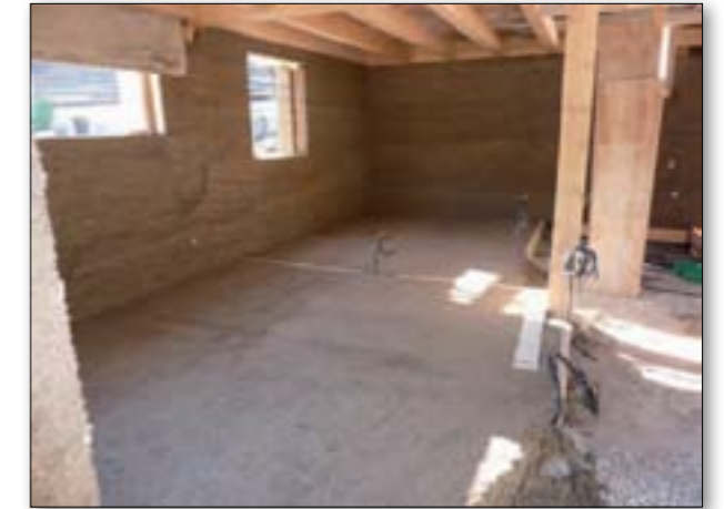
Bodenplatte Einbringen der ca. 20 cm starken Bodenplatte aus Hanfbeton
