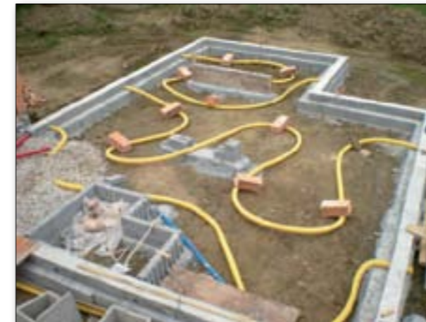
Drainage und Bodenplatte
