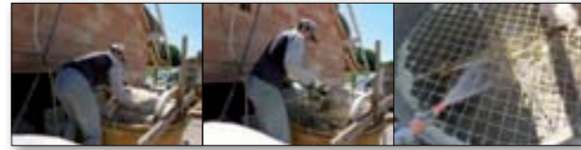
Anmischen des Hanfbeton
