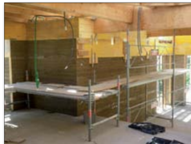
eingetragen und dabei an der Schalungswandung und um die Stützbalken zusätzlich verdichtet.
