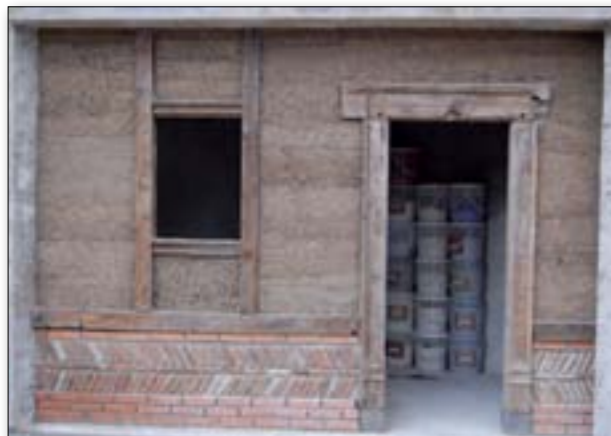
Ausmauern von altem und neuem Holzfachwerk
