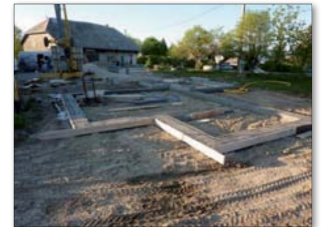
Fundamente Betonieren der Streifenfundamente
